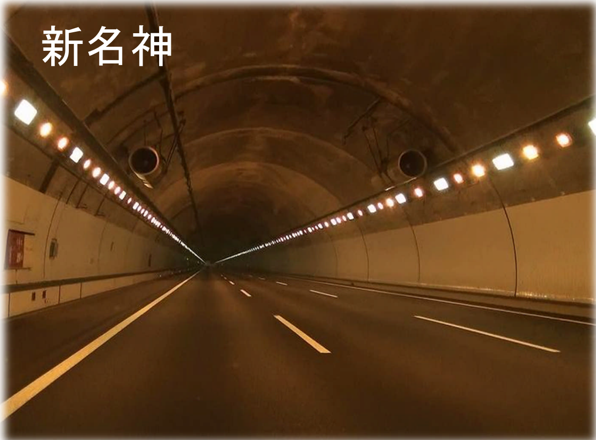
三重県境付近 鈴鹿トンネル内（下り）
